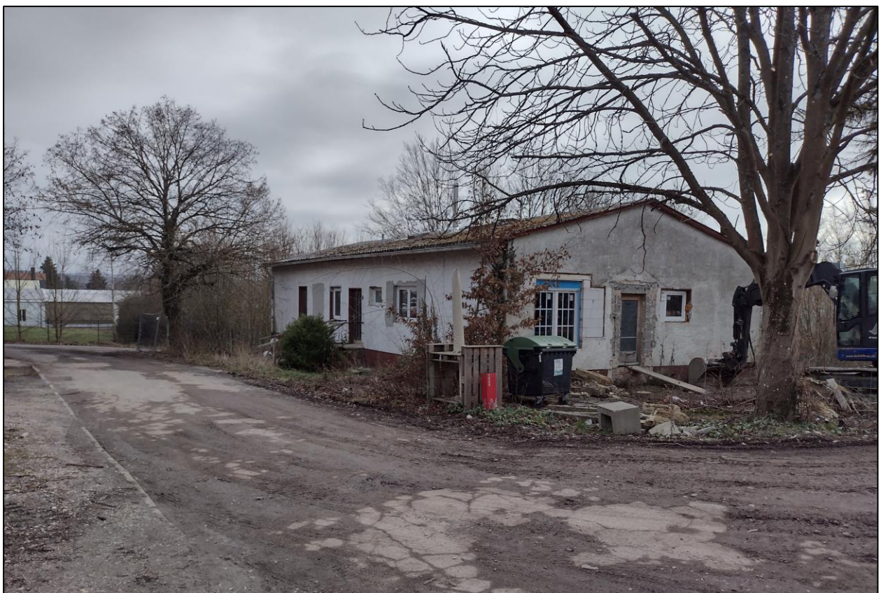
Abbildung 17: Blick auf eines der Bestandsgebäude. (IBU, 2023)
