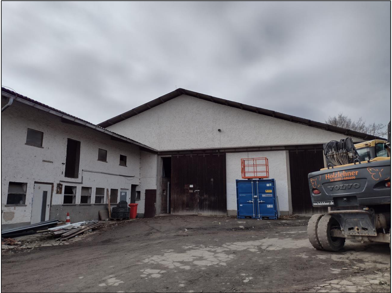
Abbildung 18: Ehemalige Lagerhalle im Plangebiet. (IBU, 2023)
