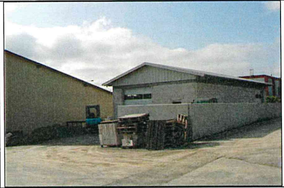
Foto 8: Gebäudebestand, Parzelle 111/1 sowie versiegelte Bereiche
