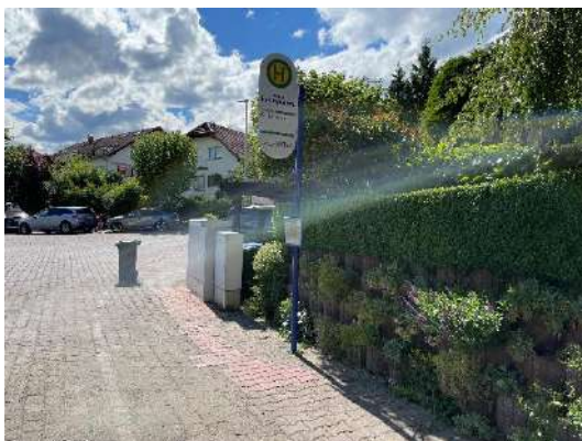
Abbildung 82: Fehlender Kontrast als Trennung zwischen Fahrbahn und Seitenraum (Bartholomäus-Arnoldi-Straße/ Emminghausstraße | Mangel Nr. 165)
