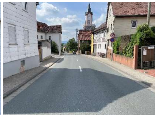
Abbildung 36: Unzureichende Gehwegbreiten in der Usinger Straße (Eschbach)
