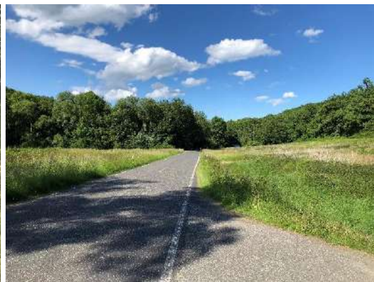
Abbildung 33: Fehrender Gehweg an der Friedrichsthaler Straße
