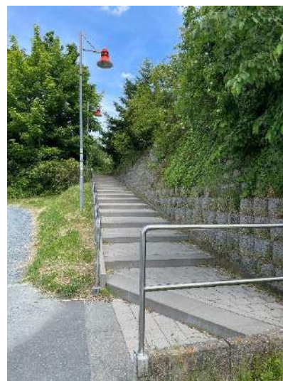
Abbildung 112: Aufgang zum Bahnhof Wilhelmsdorf
