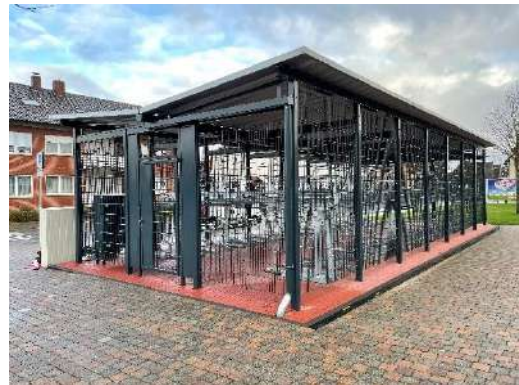
Abbildung 104: Abschließbare Sammelschließanlage mit integrierten Gepäckschließfächern am Bahnhaltelpunkt Selm-Beifang 28
