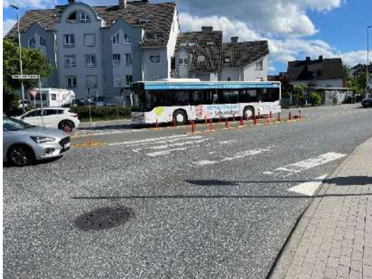
Abbildung 80: Fehlende taktile Leitelemente an der Einmündung L3270/ B456 (Mangel Nr. 175)
