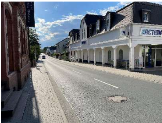
Abbildung 76: Fehlende Querungsstelle auf der Neutorstraße (Höhe Supermarkt „Action“ | Mangel Nr. 32)
