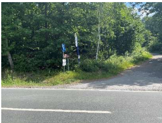
Abbildung 90: Fehlende Querungsanlage auf der Michelbacher Straße (Höhe Haltestelle „Eschbacher Klippen“) (Mangel Nr. 230)
