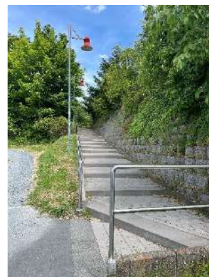
Abbildung 83: Fehlender barrierefreier, niveaugleicher Zugang zum Bahnhaltelpunkt Wilhelmsdorf von der Wilhelm-Heinrich-Straße aus (Mangel Nr. 246)
