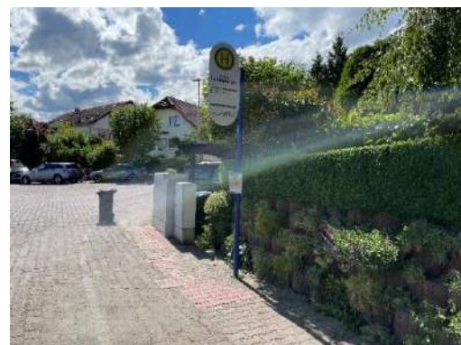
Abbildung 39: Unzureichender Kontrast und fehlende taktile Elemente zwischen Fahrbahn und Seitenraum (Emminghausstraße./ Bartholomäus-Arnoldi-Str.)
