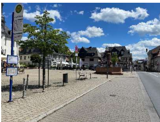
Abbildung 47: Fehlende Barrierefreiheit und fehlender Fahrgastunterstand an der Haltestelle „Alter Markplatz“
