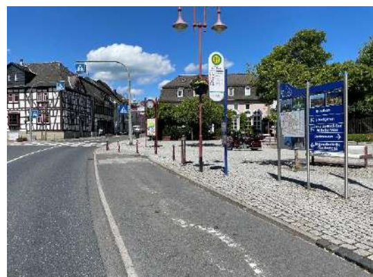
Abbildung 48: Fehlende Barrierefreiheit und fehlender Fahrgastunterstand an der Haltestelle „Schloßplatz“
