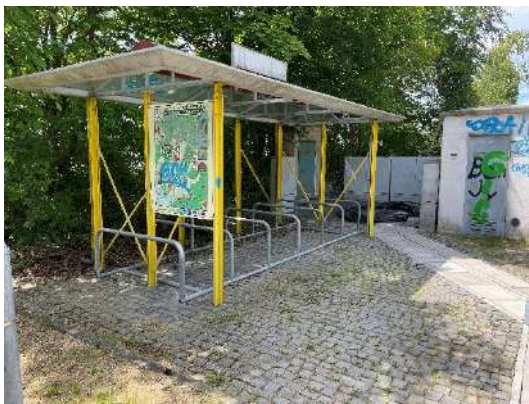
Abbildung 101: Radabstellanlage am Bahnhof Wilhelmsdorf
