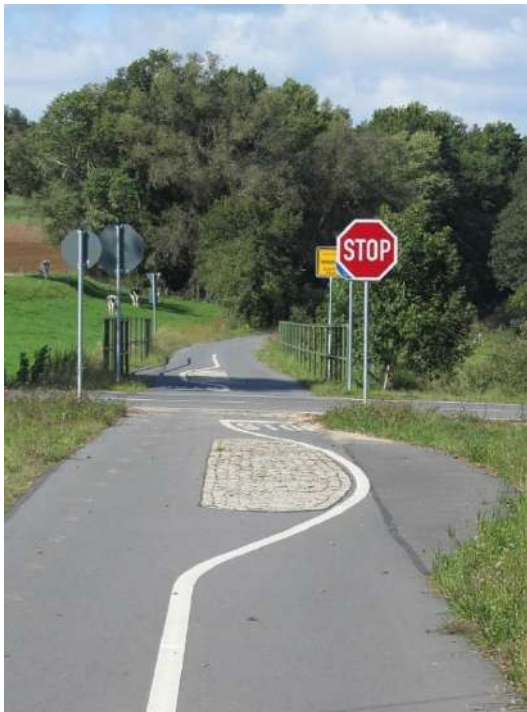
Abbildung 97: Gute Absicherung einer Querung außerorts: 'Rüttelinsel' statt Umlaufsperrn 24
