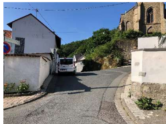
Abbildung 106: Sichtbehinderung an der Einmündung „Hauptstraße/ Haingasse“ (Mangel Nr. 143)
