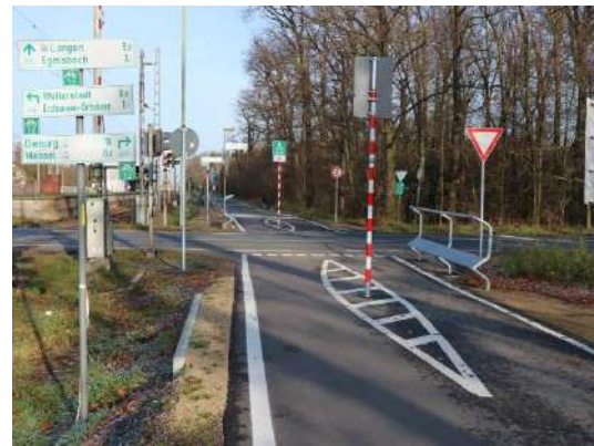
Abbildung 96: Beispiel für eine effektive Absperrung eines Radweges vor dem Kfz-Verkehr und gleichzeitige Fahrbahnteilung 22
