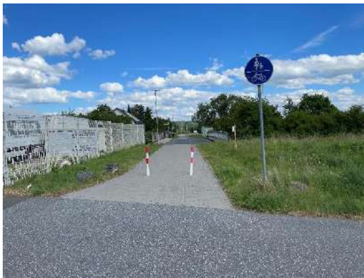
Abbildung 93: 3 Poller zur Absperrung eines Geh-/Radweges im Achtzehnmorgenweg (Mangel Nr. 56)
