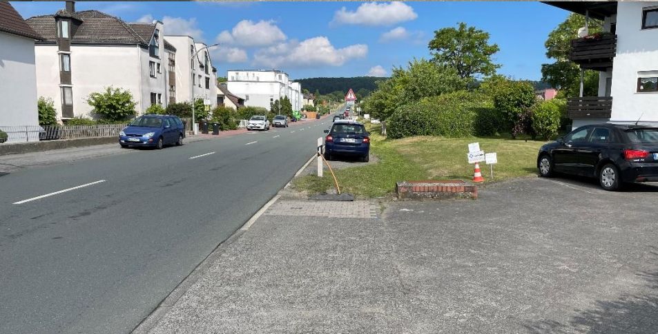
Fehlender Gehweg (Netzlücke)
