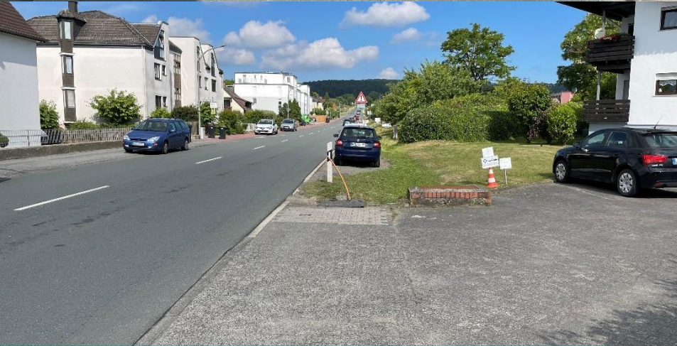
Fehlender Gehweg (Netzlücke)
